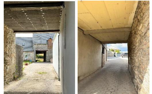
Enduit et rejointoiement au ciment, surépaisseur de l'enduit, teinte de l'enduit
