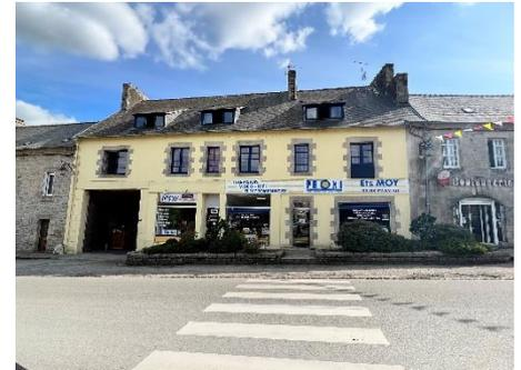
Menuiseries grand jour (effet de réverbération), disparition des volets battants, coffres de volets roulants apparents, dessin des menuiseries (fenêtres et portes) non cohérent avec l'architecture
