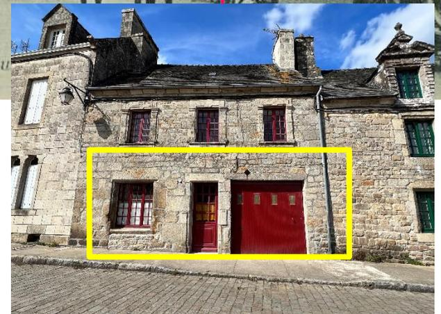
Modification du rez-de-chaussée : élargissement de la fenêtre de gauche et percement d'une porte de garage à la place d'une fenêtre
